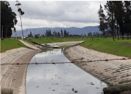
Foto No. 4. Sistema de bombeo Canal Cundinamarca
