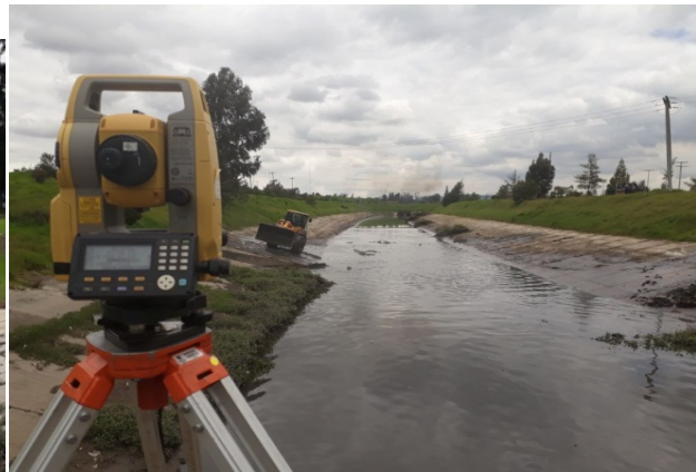
Foto No. 5. Mantenimiento y retiro del material extraído
